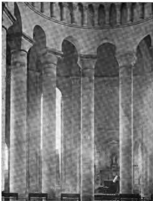
Fig. 133. — Voûte annulaire du déambulatoire contournant l'abside à voûte hémisphérique de l'église abbatiale de Fontevault (Maine-et-Loire).
